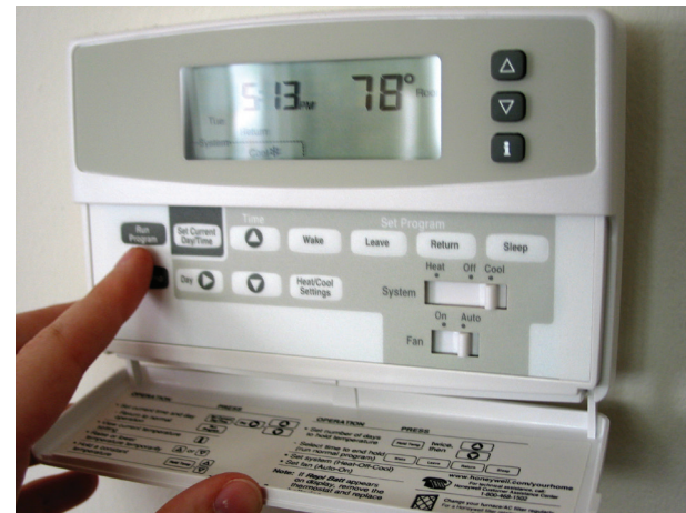
El termostato programado ofrece cuatro periodos de programación: despertar, salir, retorno y dormir.
